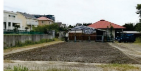
2020.5 復旧作業と整地化
