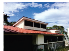
2020.7 第一期工事完了 (男子風呂、トイレ)
