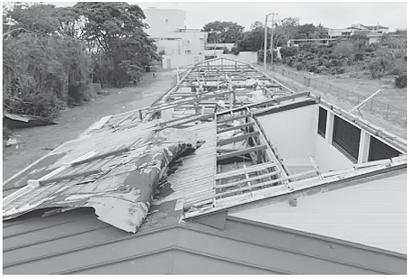
母校の臨海教室や同窓生の宿泊などの用に供しております館山寮（旧 塩見寮）は台風十五号の強風により男子棟の屋根が吹き飛ばされ全壊と認定される
